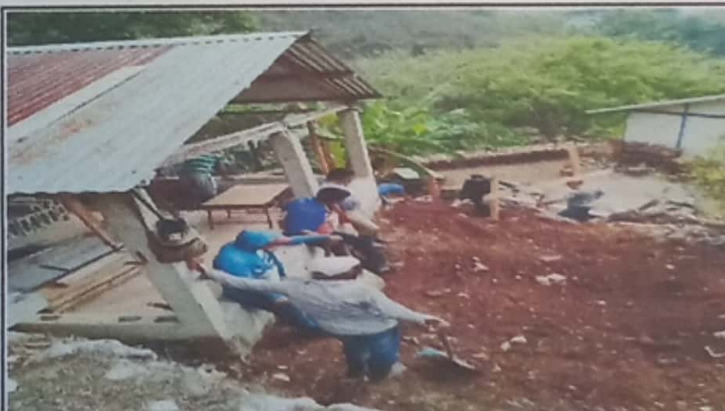
Foto 6: MEJORAMIENTO DE MURO DE CONTENCION
