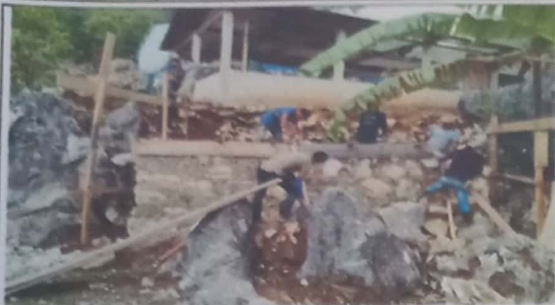
Foto 1: MEJORAMIENTO DE MURO DE CONTENCION
