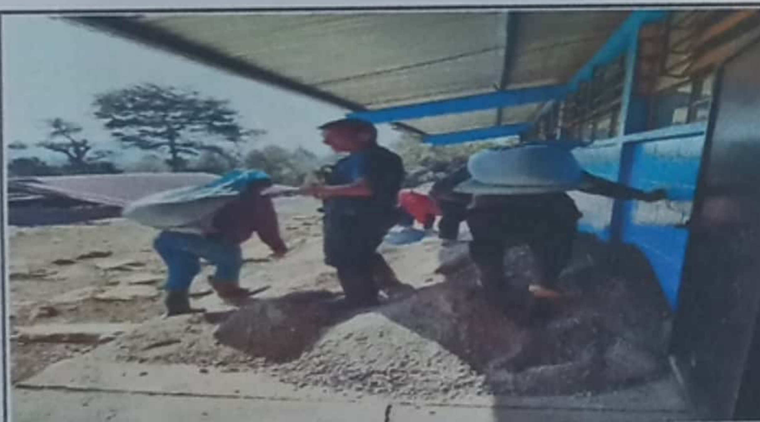
Foto 5: AMPLIASION LOSA DE PATIO
