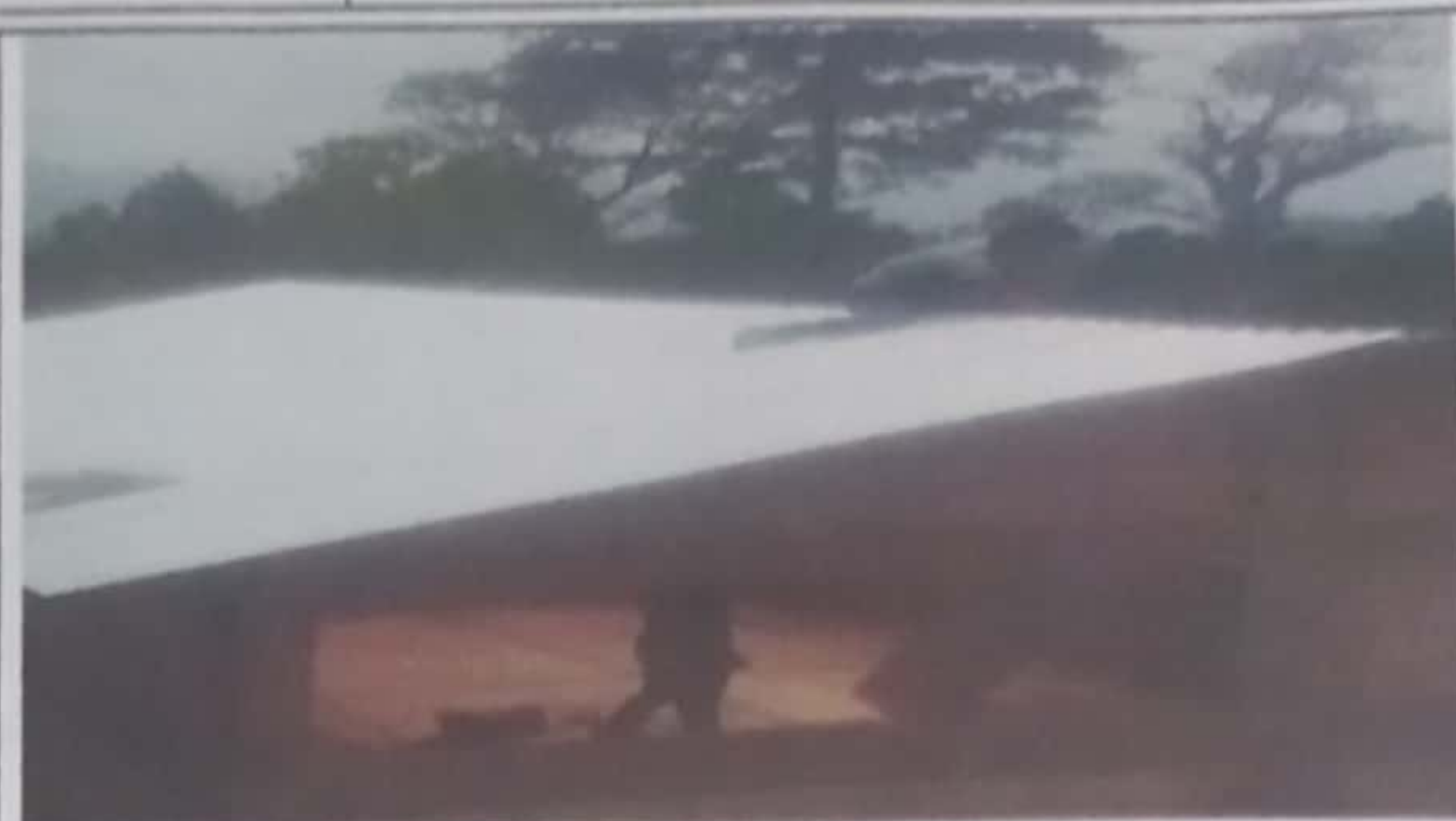
Foto 2: INSTALACION DE CUBIENTO DE TECHO
