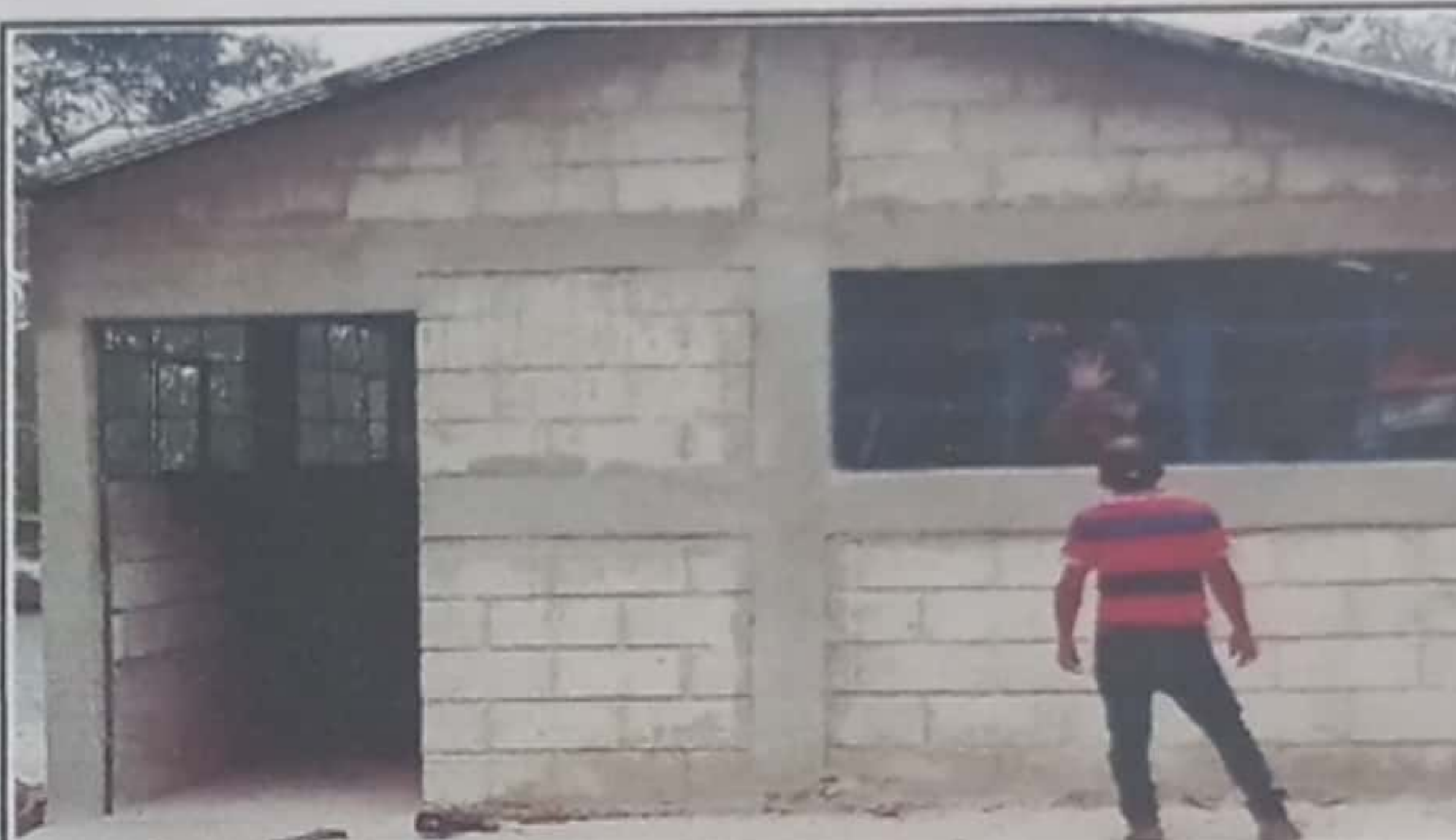
Foto 4: INSTACION DE PUERTAS Y VENTANAS
