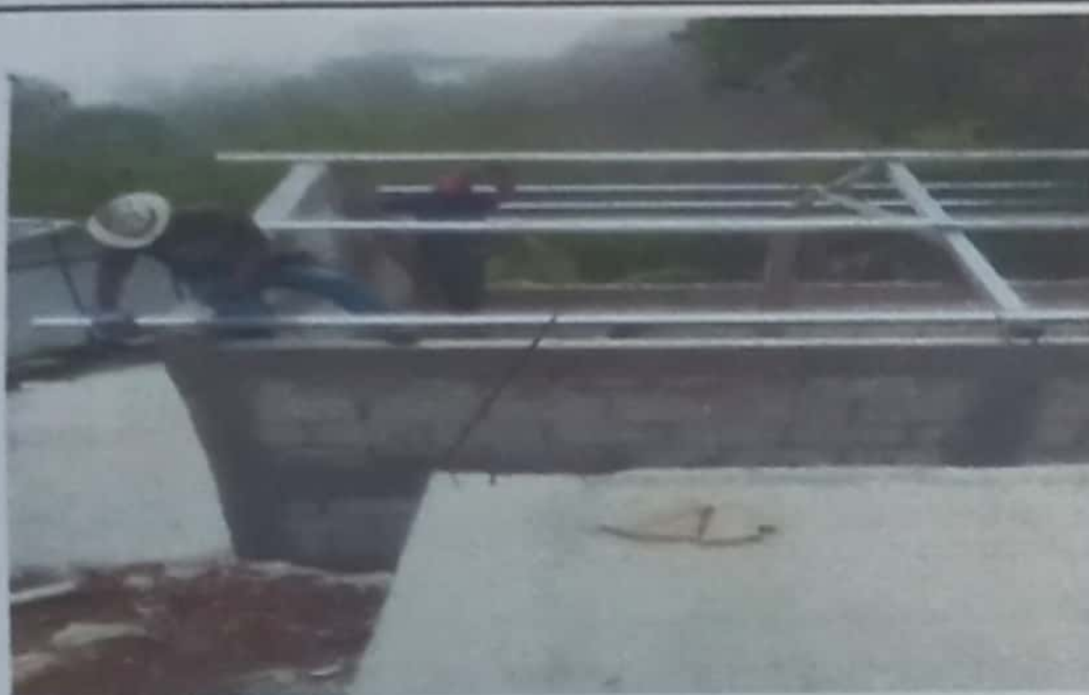
Foto 3: CAMBIO DE ESTRUCTURA DE MADERA POR METAL
